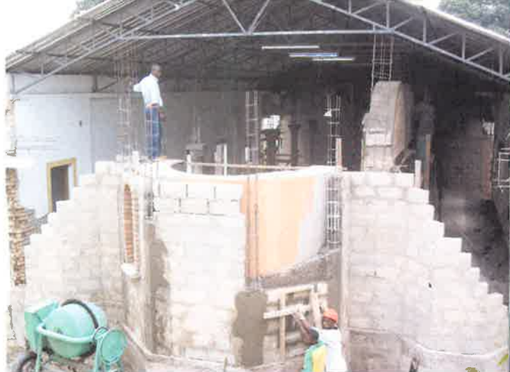
Ἡ κατασκευή τῆς κόγχης τοῦ ἱεροῦ
