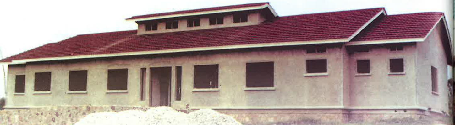
Δείγμα από τό οικοδομικό έργο τής Έπισκοπής
