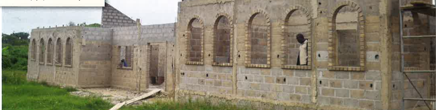
Τό ὑπό κατασκευή ἱατρεῖο-κλινική στό Pointe Noire μέ ἐνσωματωμένο Ναῖδριο τοῦ Ἁγίου Λουκά Συμφερουπόλεως.
